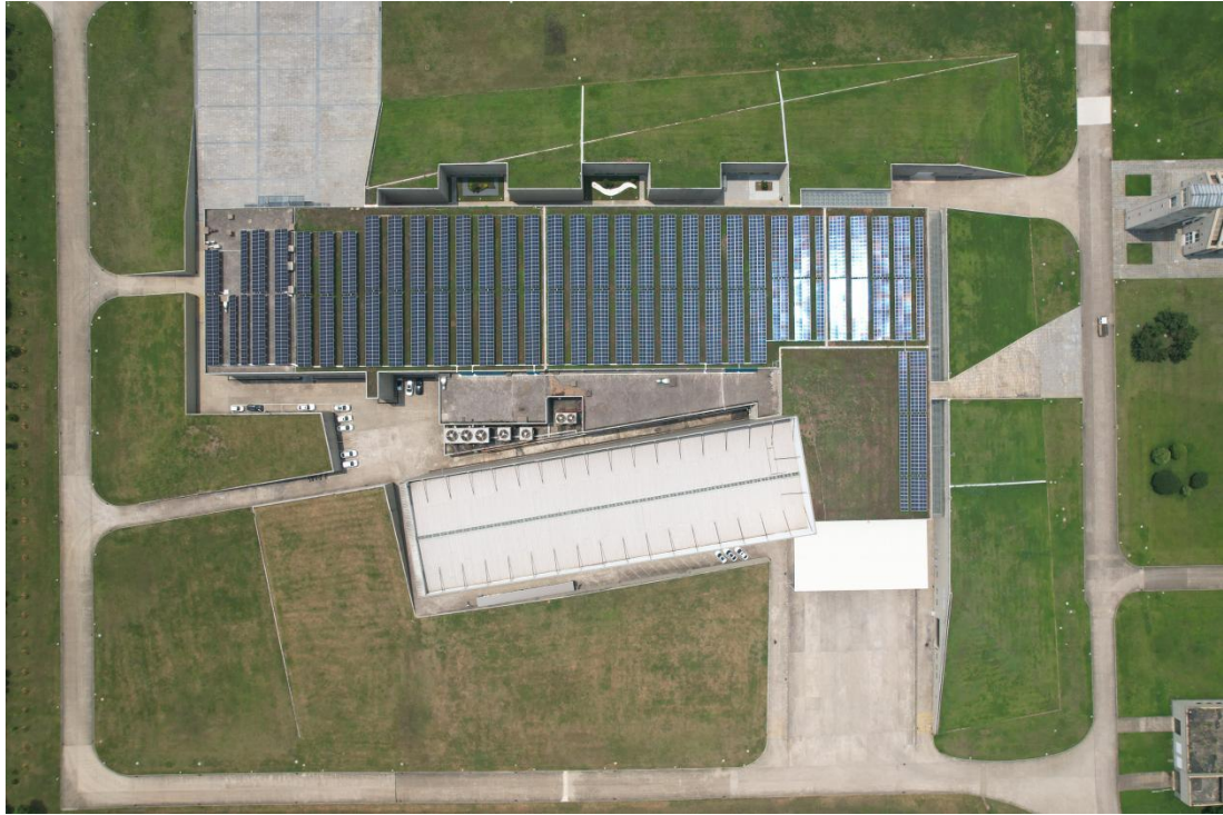
图. 湾里制造基地二期光伏发电项目
